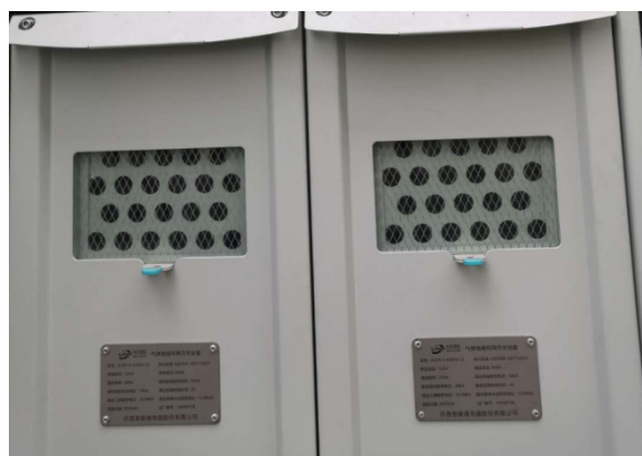
图 7 10kV 梧廉线玉伍廉租房环网柜电缆室照片
