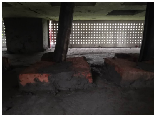
图 8 环网柜基础中间层垫高部分及箱底。
