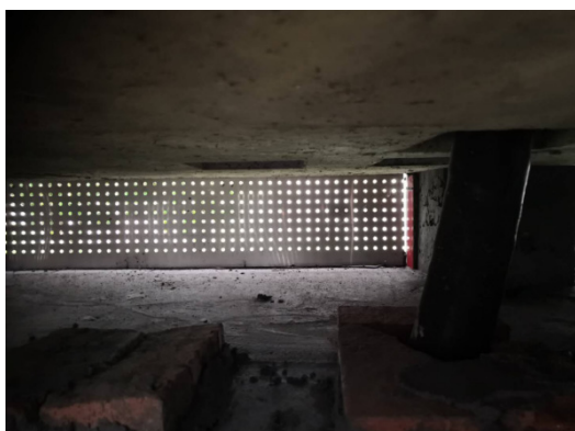
图 8 环网柜基础中间层垫高部分及箱底。
