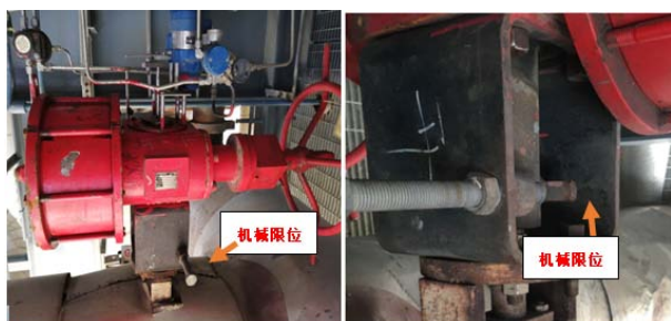
图2 机械限位未安装到位
