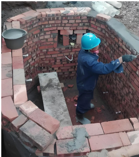
图 1 人孔砌筑的现场情景
