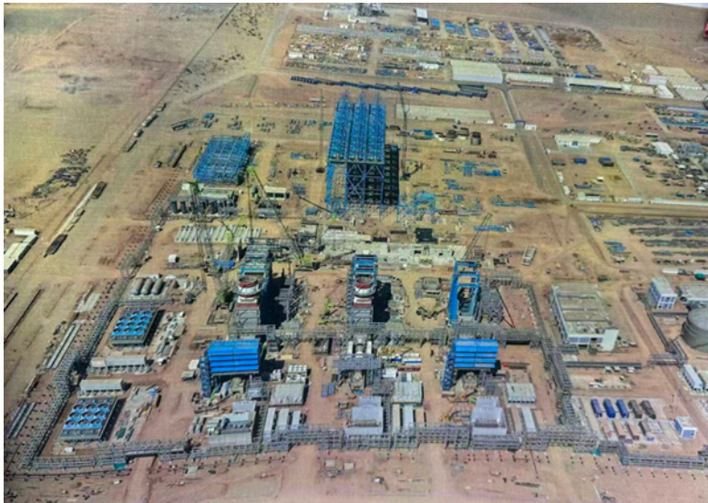
图 1 沙特项目现场航拍
