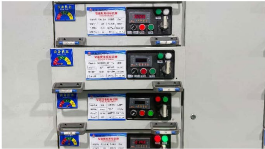
低压配电柜改造
