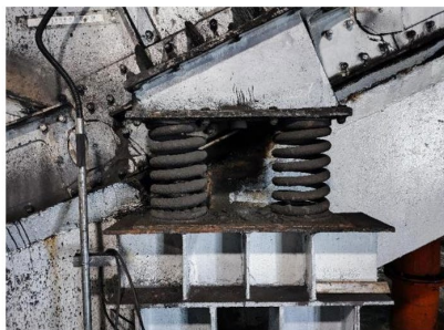
(a) 改造前:钢制螺旋弹簧
