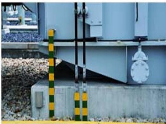
图2 近几年铁芯、夹件经套管引出
