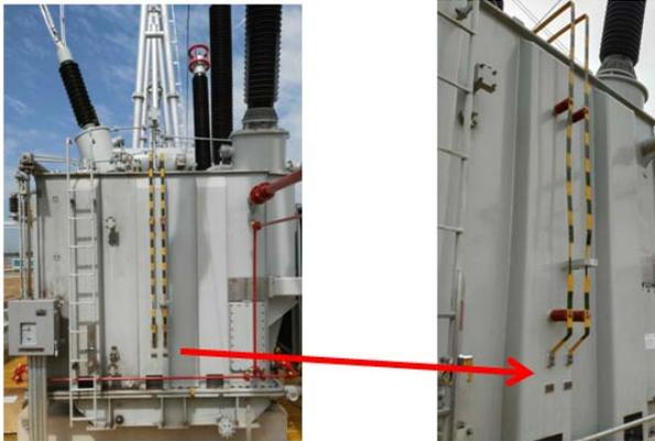
图 5 现场实际接法
