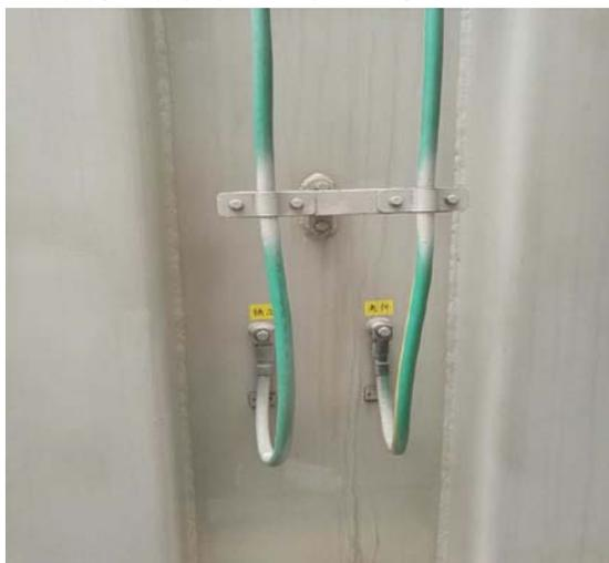
图1 以前铁芯、夹件经套管引出
