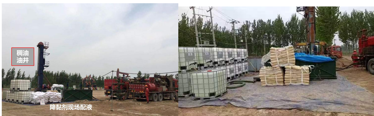
图5 胜利油田东部注降黏剂冷采现场
